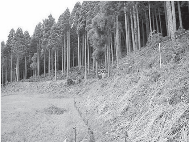
勝山市内の被害対策の様子
