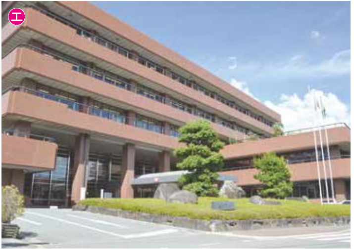
答え：生駒市役所庁舎
